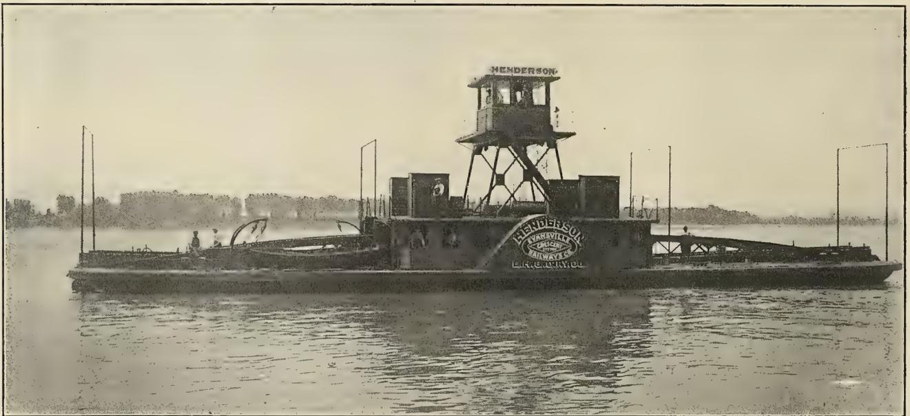
FIG. 1.—SIDE-WHEEL CAR FERRY HENDERSON DRIVEN BY GASOLINE (PETROL) ENGINES
